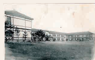
盛岡市立仁王尋常小学校 改築校舎
